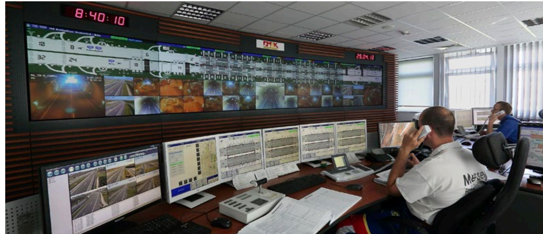
Macaristan'da bulunan M6 Otoyolu KÖİ projesi kapsamında beş kilometrelik tünel zincirinin Intertoll tarafından işletilen İzleme Kontrol Odası. Tunnel Monitoring Control Room operated by Intertoll on the M6 Motorway PPP in Hungary for a five kilometers-long tunnel chain.
