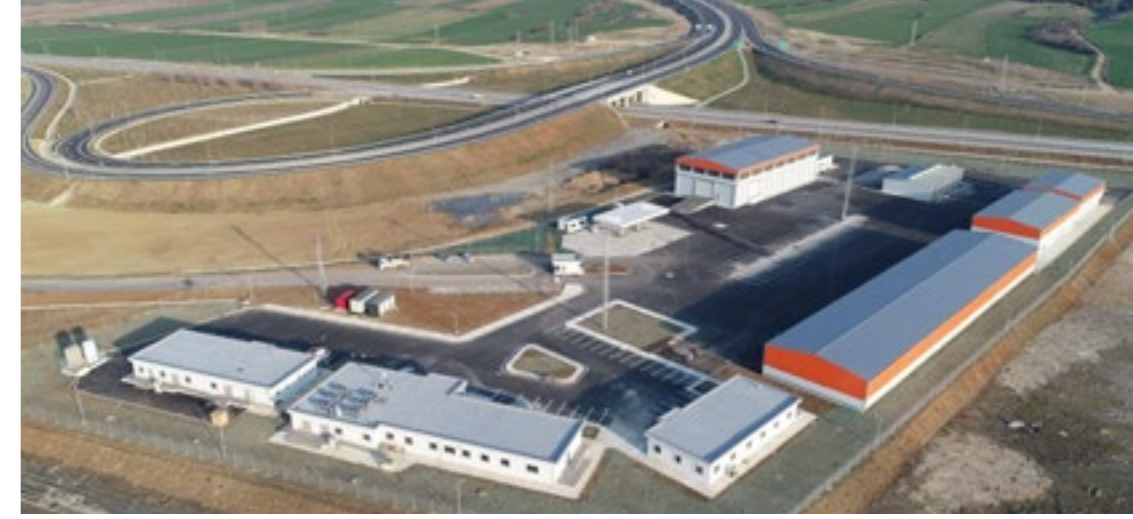
Kavakköy Bakım İşletme Merkezi. Kavakköy Maintenance and Operation Center.
