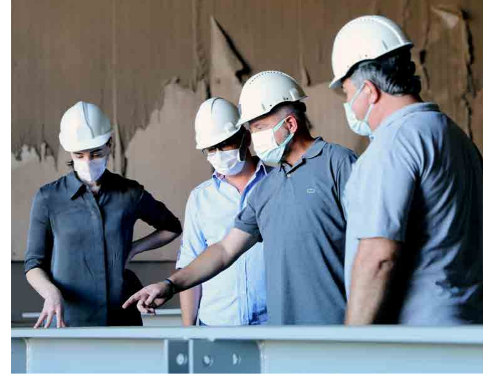
"LG Barge Support" boya sonrası kontrol ve kalınlık ölçümü. Paint inspections and thickness checks on the Lifting Gantry Barge Supports.
