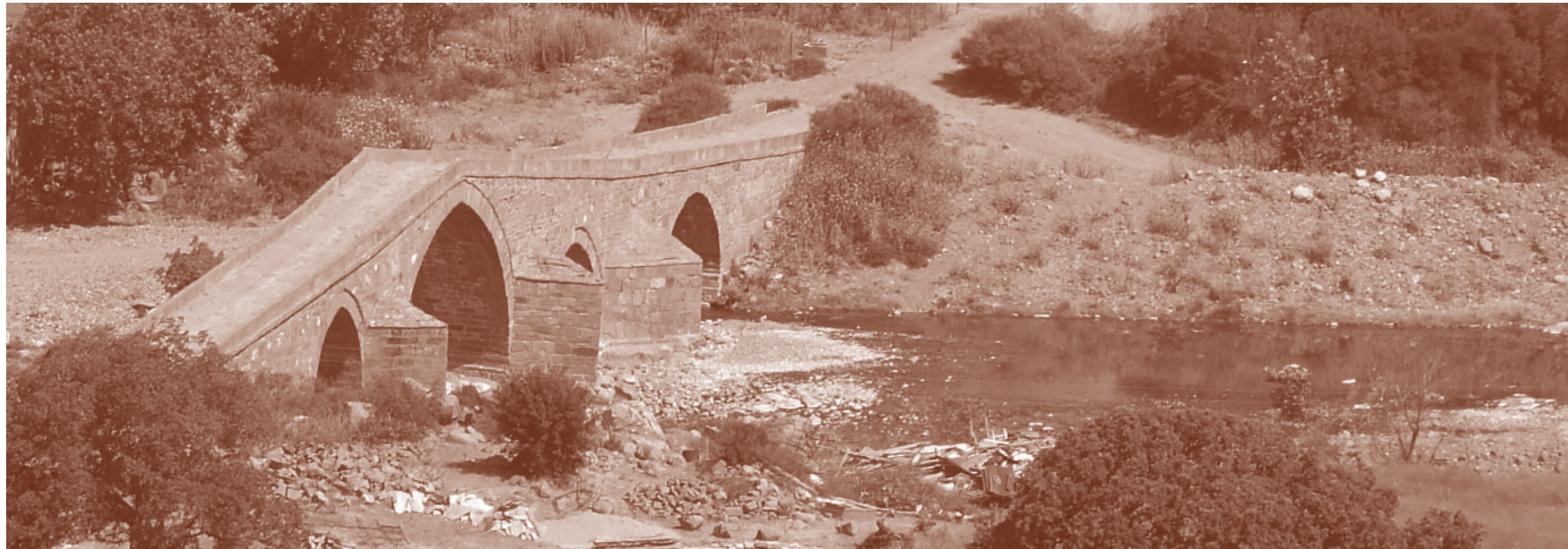
Behramkale Köprüsü. Behramkale Bridge.
