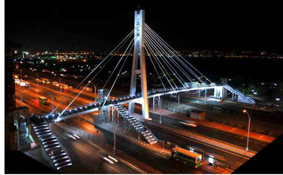
D100 Yolu Yaya Geçitleri / İZMİT Eğik Askı. Pedestrian crossings on D100 / İZMİT Cable-Stay works.
