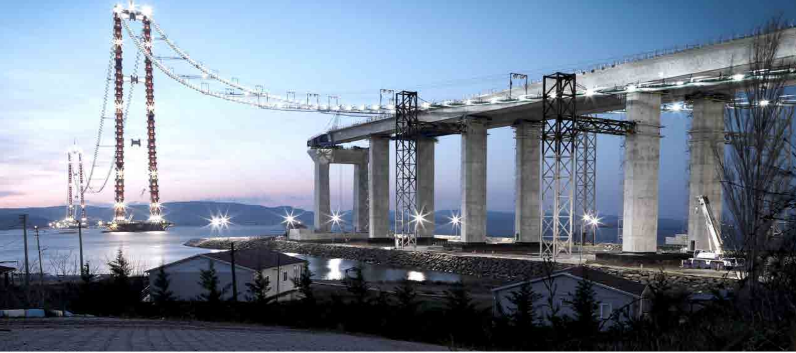
1915Çanakkale Köprüsü Yaklaşım Viyadükleri. 1915Çanakkale Bridge approach viaducts.
