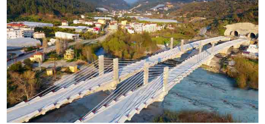
Alanya Dim Çayı Köprüsü Ekstra Doz-Ardgerme. Alanya Dim Çayı Bridge Extradose and Post-Tensioning works.
