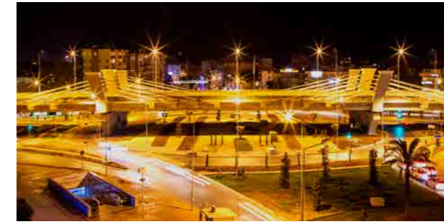
Antalya Çallı Köprüsü Ekstra Doz-Ardgerme. Antalya Çallı Bridge Extradose and Post-Tensioning works.
