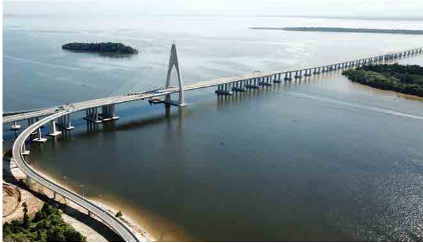
Brunei'nin en uzun gergi askılı köprüsü Temburong. Brunei's longest cable-stayed bridge Temburong.
