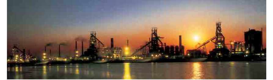
Posco Çelik Fabrikası. Posco Steel Factory.
