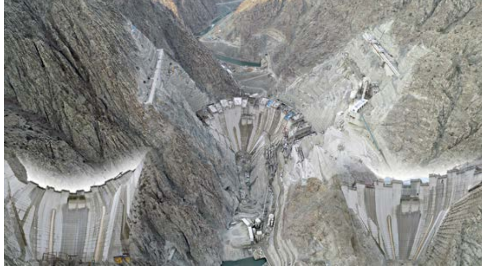
Artvin Yusufeli Barajı Artvin Yusufeli Dam
